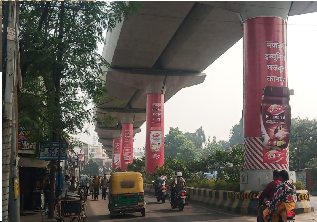
Metro Pillar Wrap
